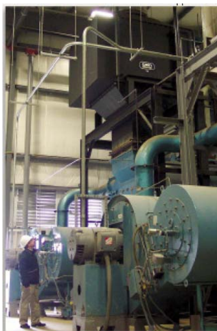
รูปที่ 3.7 การเชื่อมต่ออุปกรณ์ทำน้ำร้อนที่ปล่องไอเสียของหม้อไอน้ำ
